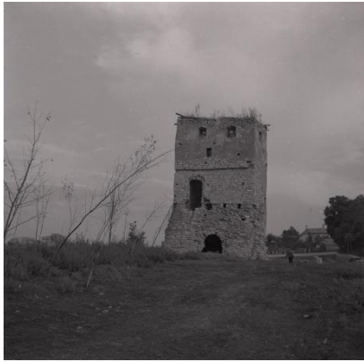
Рис. 1. Фот. А. Д. Тютіч. - Київ, 1965. // Матеріали з фондів Державної наукової архітектурно-будівельної бібліотеки ім. В.Г. Заболотного
