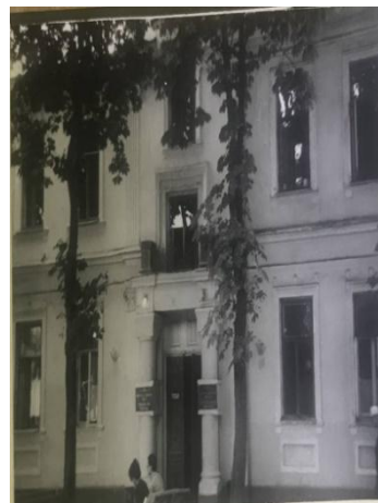
Рис.4. Фото 1970-х рр. Головний фасад будинку по вул. Гунській, 9
