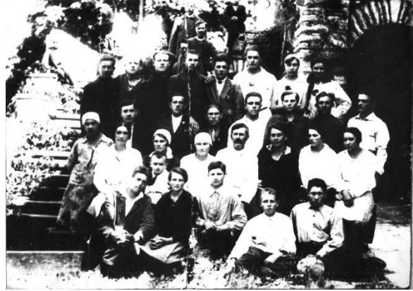
Рис 2. Фото 1931 року. Фрагмент північного фасаду
