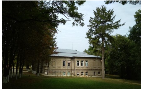
Рис 8. Загальний вигляд будинку з південно-східного боку
