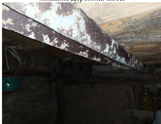
Рис. 14. Залізничні рейси, використані для перекриття даху погребу в с. Суботів
