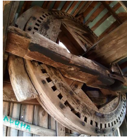
Рис. 4. Внутрішній механізм вітряка в с. Суботів
