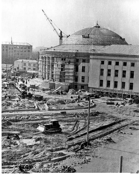
Рис. 2. 1959 рік. Будівництво цирку на Площі Перемоги в Києві
