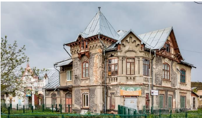
Рис. 7. Загальний вигляд будинку
